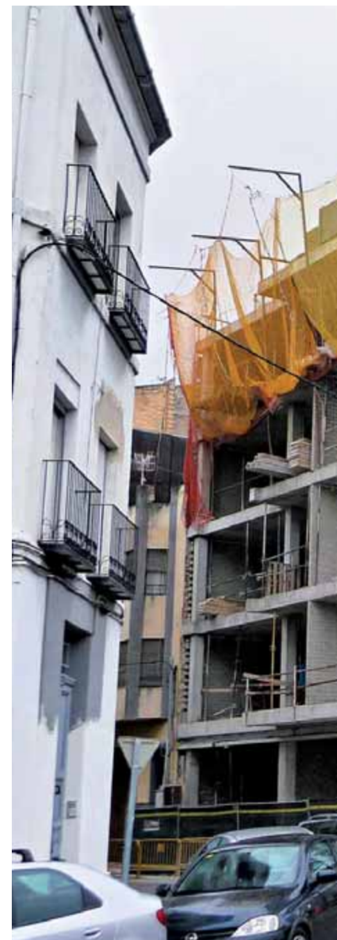
A l'esquerra, obres aturades d'un edifici d'habitatges
